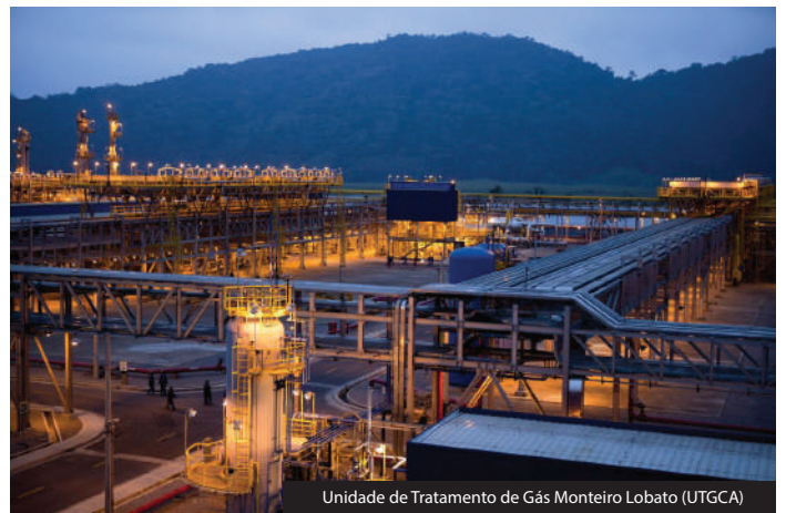
Unidade de Tratamento de Gás Monteiro Lobato (UTGCA)
