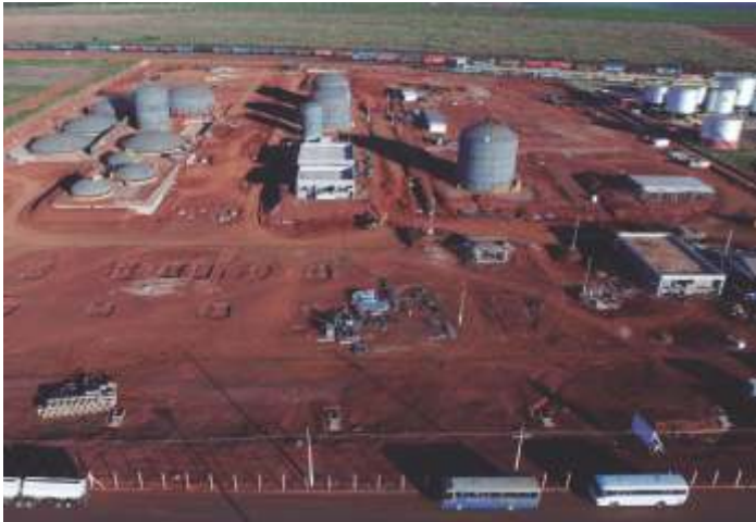
Vista aérea do Teron em construção
