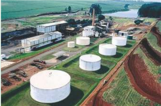
Parque de tanques da Usina Ipaussu - SP
