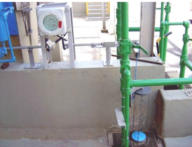
Sensor ID 223/500 e processador PS 220 da Leakwise
